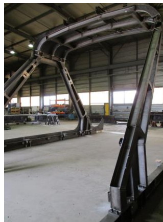
Montage d'un arceau métallique en atelier
