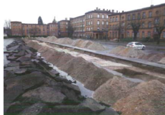
Vue générale d'une tranchée de sondage depuis l'Est (source : PAIR)
