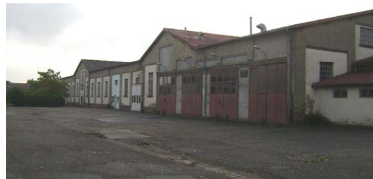
Ancien garage auto / gymnase
