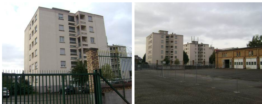
Immeubles collectifs rue des Voituriers (vus depuis la caserne Thurot)
