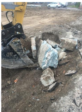
Découverte des fondations de l'ancienne gare lors des travaux de terrassement
