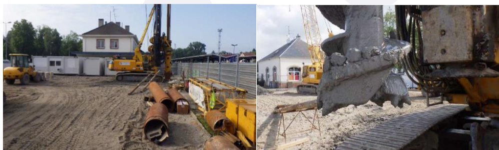
L'atelier de forage
